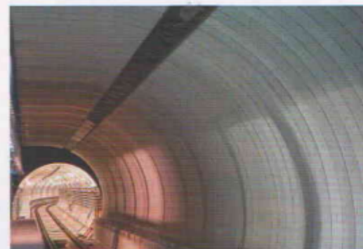
A 4-es metró tűzgátló designburkolatai
